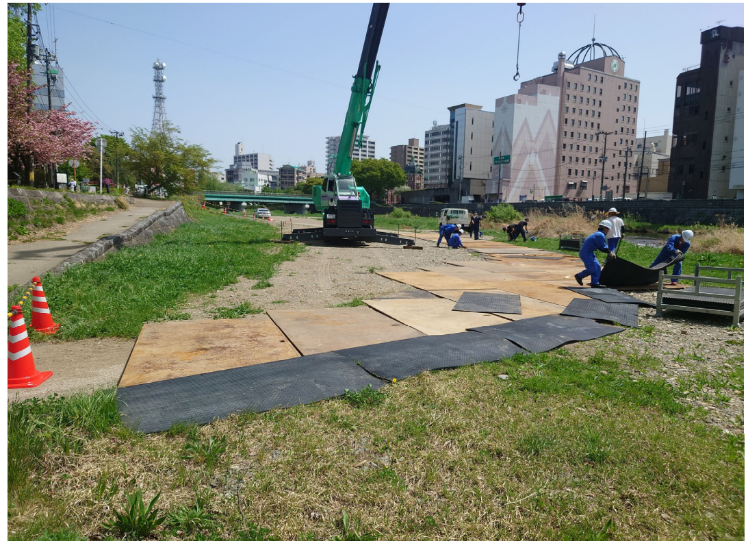
消防車が安全に通れるよう、ゴムマットを敷いて段差を少なくしていきます
