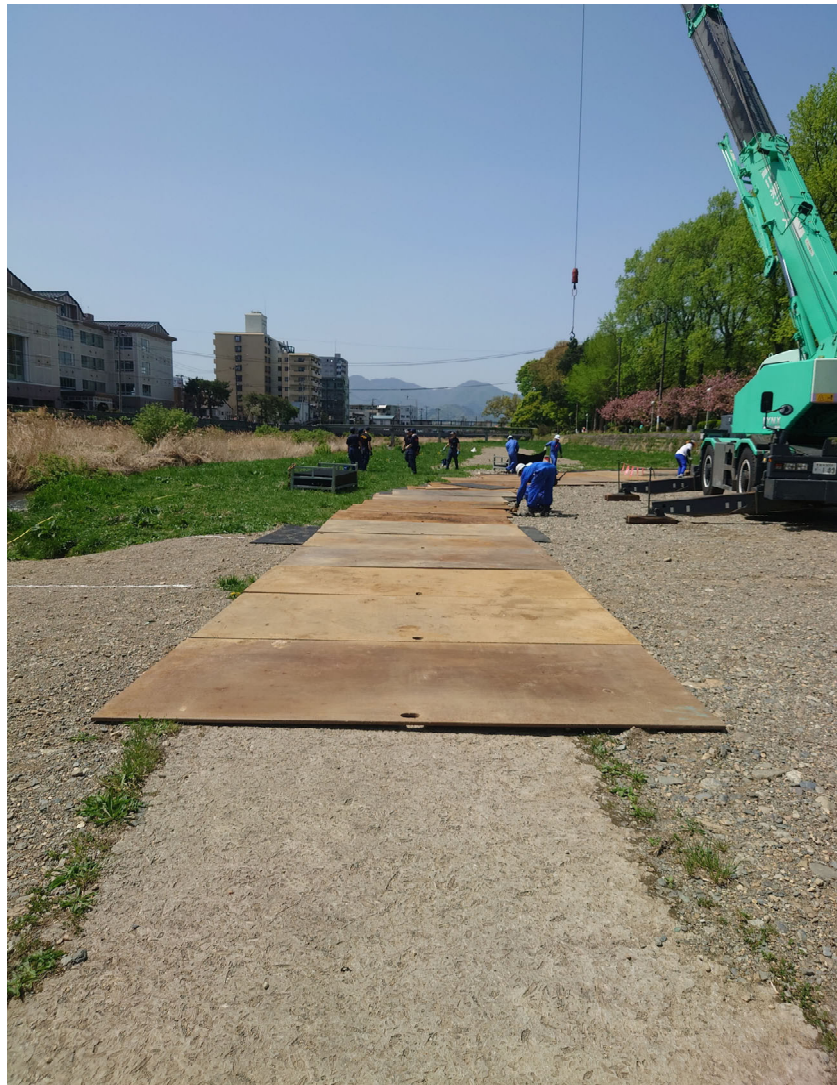
鉄板を敷き、遊歩道が壊れないように保護していきます
